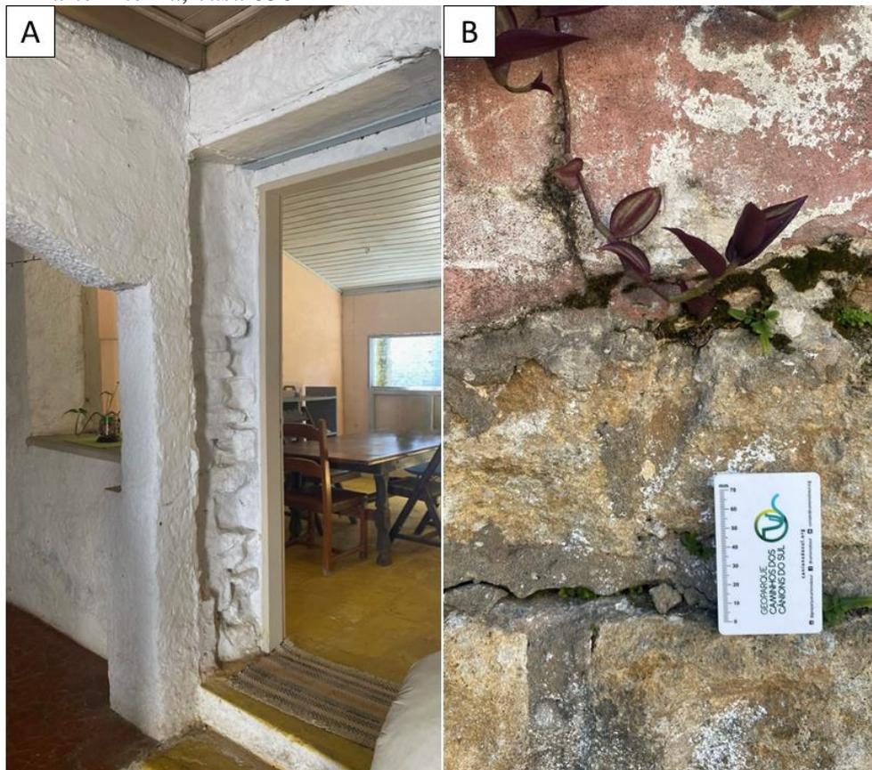
Fonte: Autora, 2025. Legenda: A. Interior da residência 838, parede que evidencia a utilização do material rochoso na construção. B. Parede externa da residência 838, basalto e arenito.
