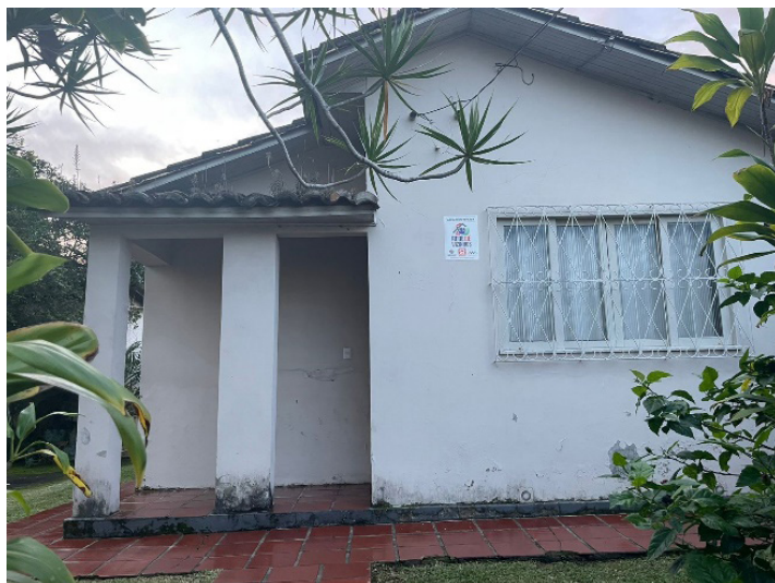
Figura 23 – Casas em alvenaria construída pela CSN, 2024 (Rua Pernambuco)
