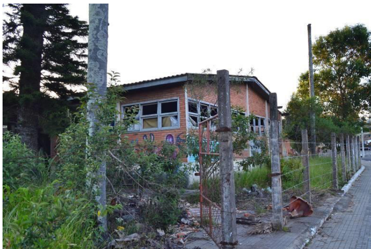
Figura 29 - Ruínas das estruturas da CSN, 2016
