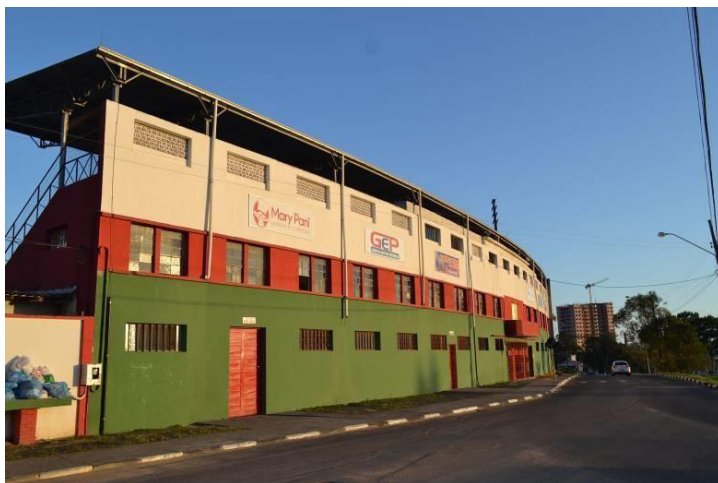
Figura 24 – Estádio Eng. Mário Balsini, Próspera, 2016
