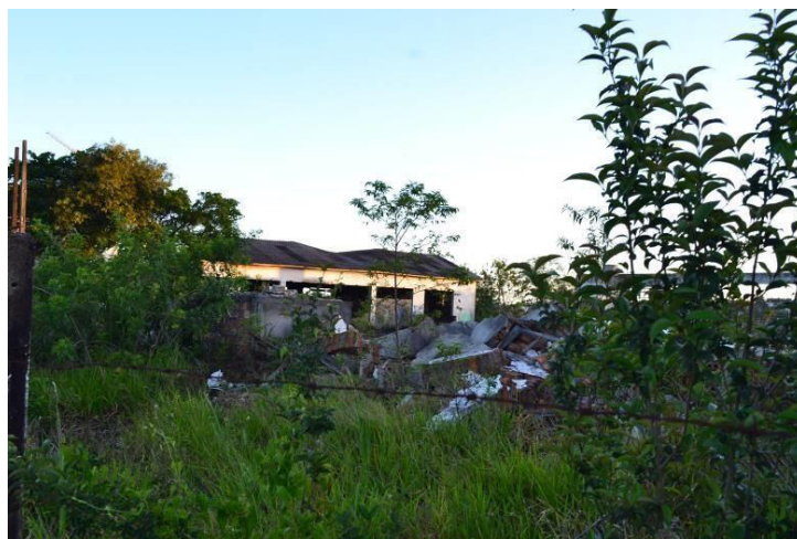
Figura 32 – Ruínas das estruturas da CSN, 2016
