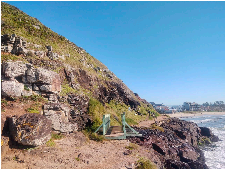
Figura 71 - Imagem da ponte que serve de acesso ao promontório. Vale ressaltar que a mesma está localizada ao alcance de processos de queda de blocos rochosos. Fonte: Elaborado pelos autores.
