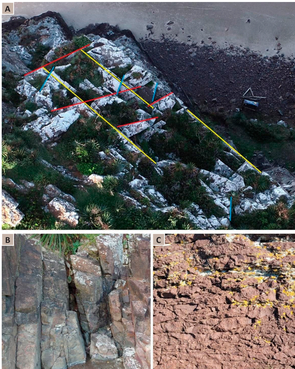
Figura 23 -A - Representação dos sistemas de falhas/fraturas que compartimentam e individualizam blocos, cujos planos ou descontinuidades, sob a ação dos agentes erosivos, contribuem para o elevado grau de risco a quedas e rolamentos desses blocos por todo o maciço rochoso. Linhas amarelas: ENE-WSW; linhas vermelhas: NNE-SSW; linhas azuis: NW-SE; B - Fraturas com mergulhos próximos ao vertical; C – Fraturas com mergulho próximo ao horizontal. Fonte: Elaborado pelos autores.
