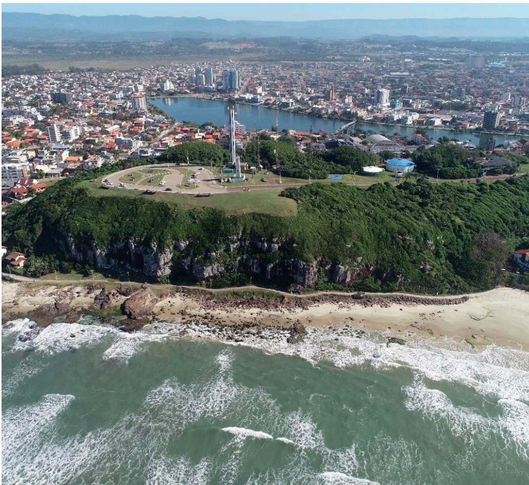
Figura 79 - Imagem exibindo vista panorâmica da Torre do Farol, com o Caminho da Santinha percorrendo sua base. Fonte: Elaborado pelos autores.
