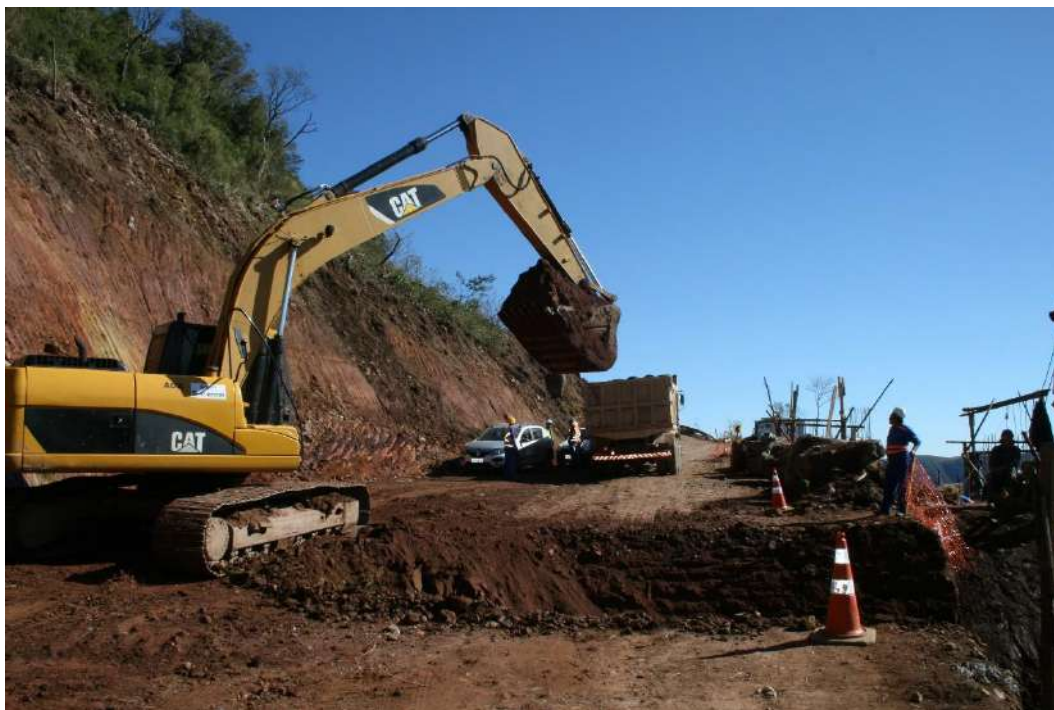
Foto 38: Detalhe das obras de pavimentação da Serra da Rocinha, rodovia BR-285.
