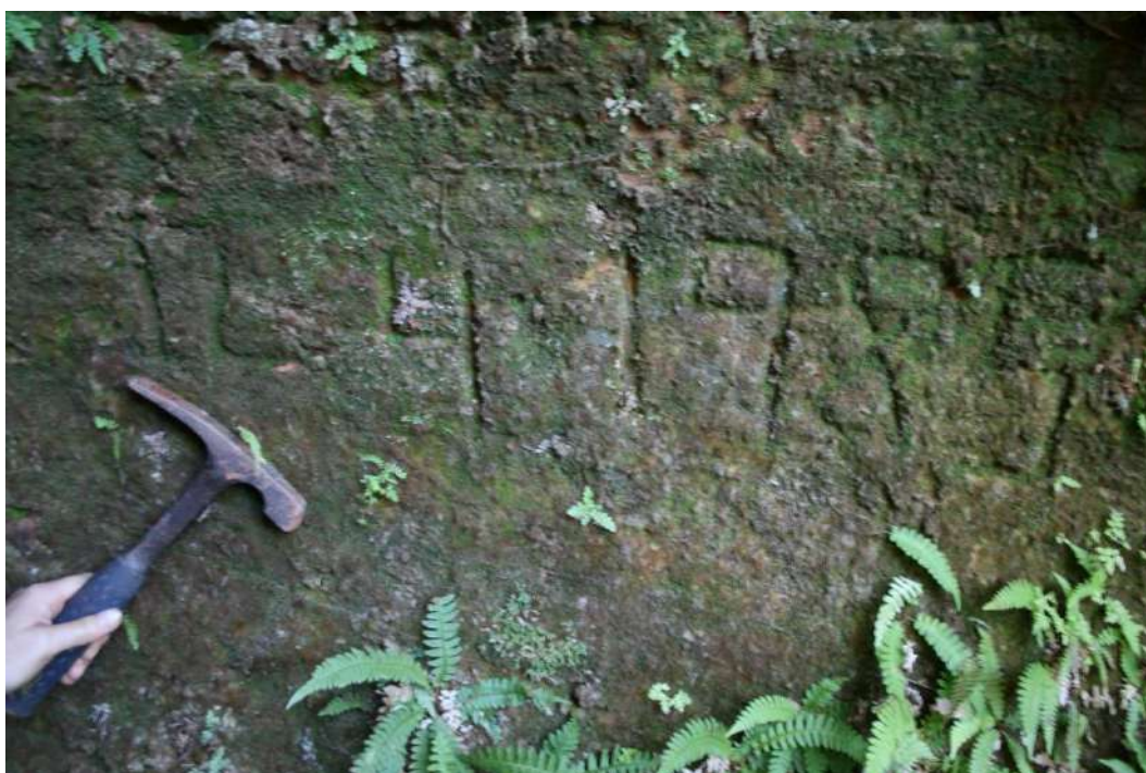
Foto 35: Evidência de degradação na parede da Paleotoca que remete a década de 80.
