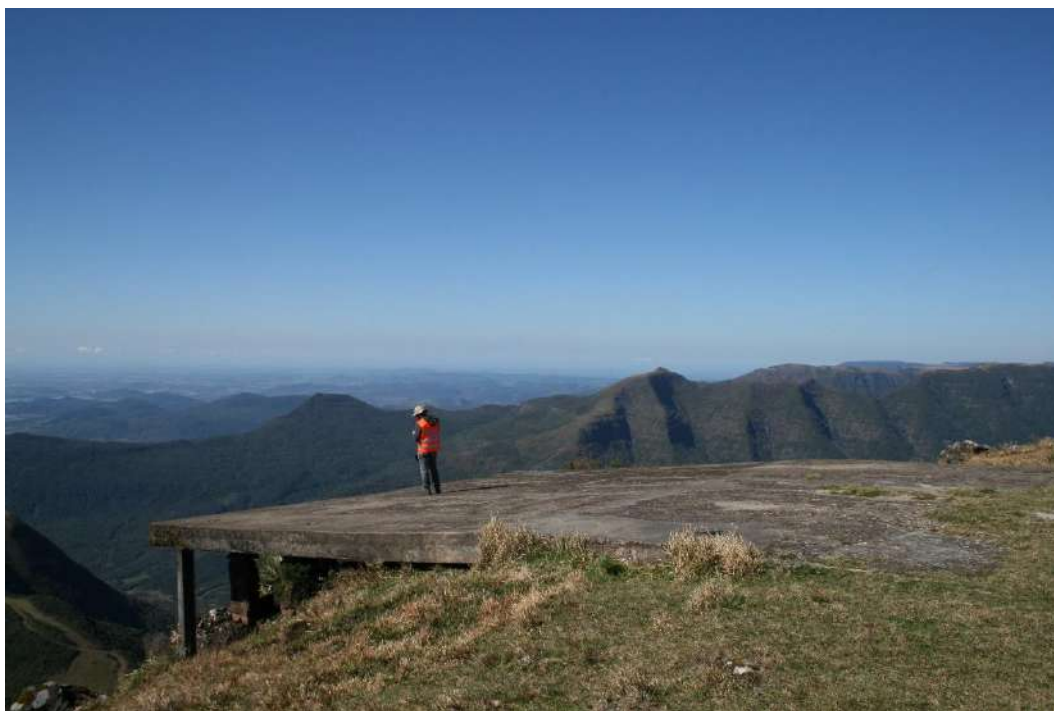
Foto 39: Estrutura de concreto atual do mirante, sem guarda corpo.
