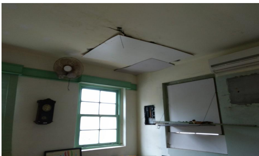
Figura 6 - Foto da área comprometida no 3º andar
