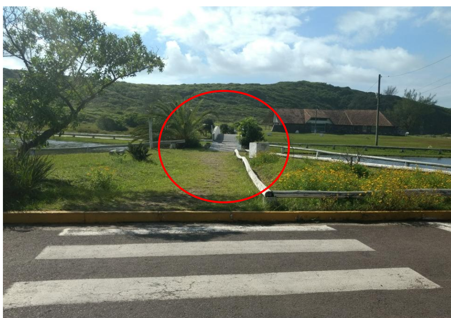
Figura 15 - Acesso da ponte da estrada até a pista de caminhada e bicicleta
